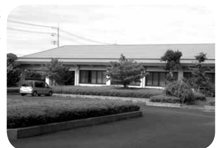
太陽光パネル設置施設
